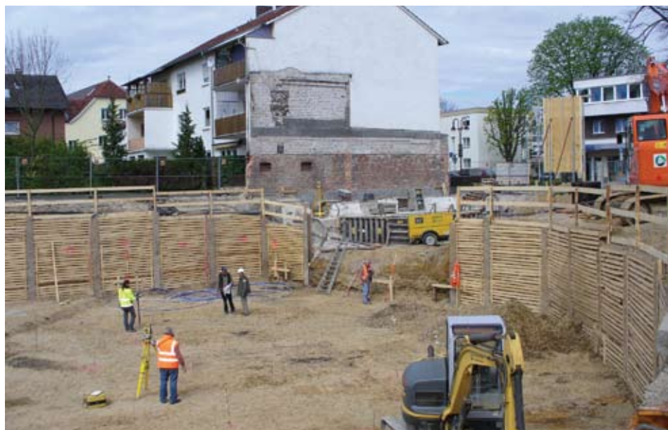
Bei den Ausschachtungsarbeiten, Abbildung: Heimat- und Verkehrsverein Elsen e.V., Foto: Josef Segin, 2012
