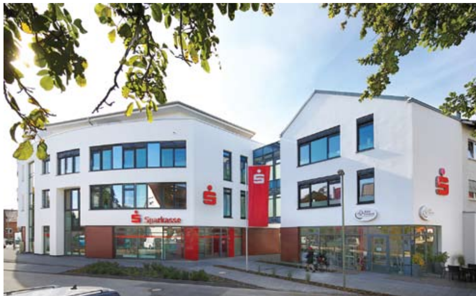
Das neu gebaute Sparkassengebäude im Oktober 2013, Abbildung: Sparkasse Paderborn, Foto: Sparkasse Paderborn
