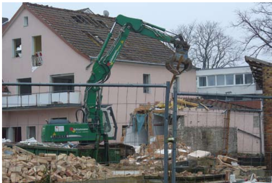
Abbrissarbeiten Kohlenlagerräume Kürpick und Haus Gehrken, Von-Ketteler-Straße 19 a und 19, Abbildung: Heimat- und Verkehrsverein Elsen e.V., Foto: Josef Segin, 2012
