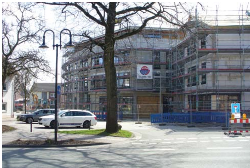
Das Sparkassengebäude ist bald fertiggestellt. Abbildung: Heimat- und Verkehrsverein Elsen e.V., Foto: Josef Segin, 2013
