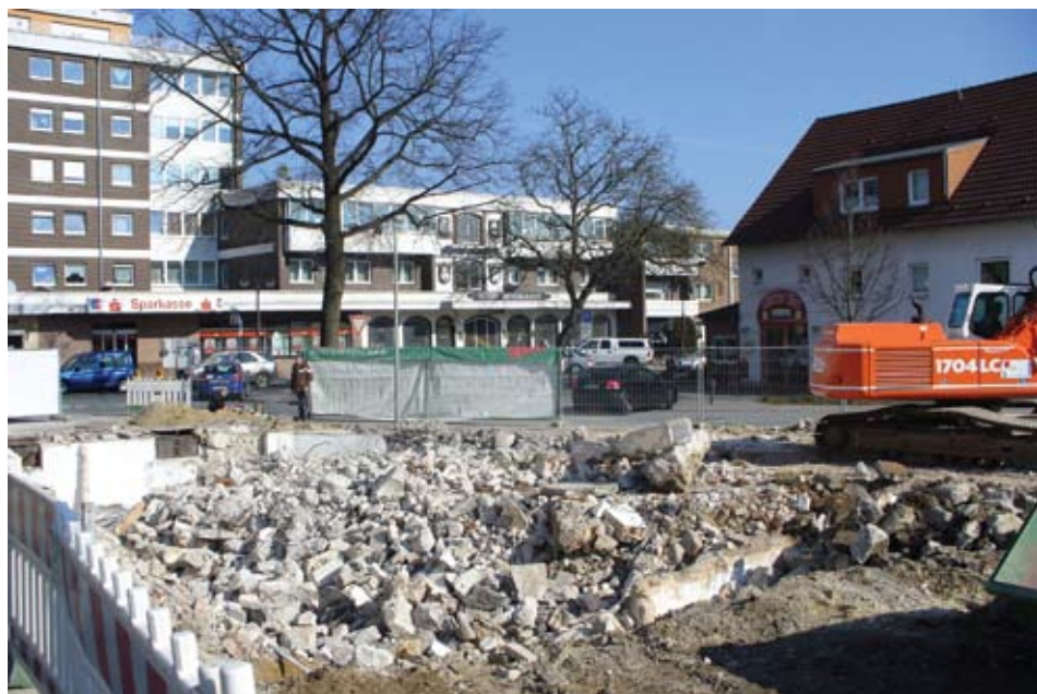
Abrissarbeiten für den Sparkassenbau, Abbildung: Heimat- und Verkehrsverein Elsen e.V., Foto: Josef Segin, 2012
