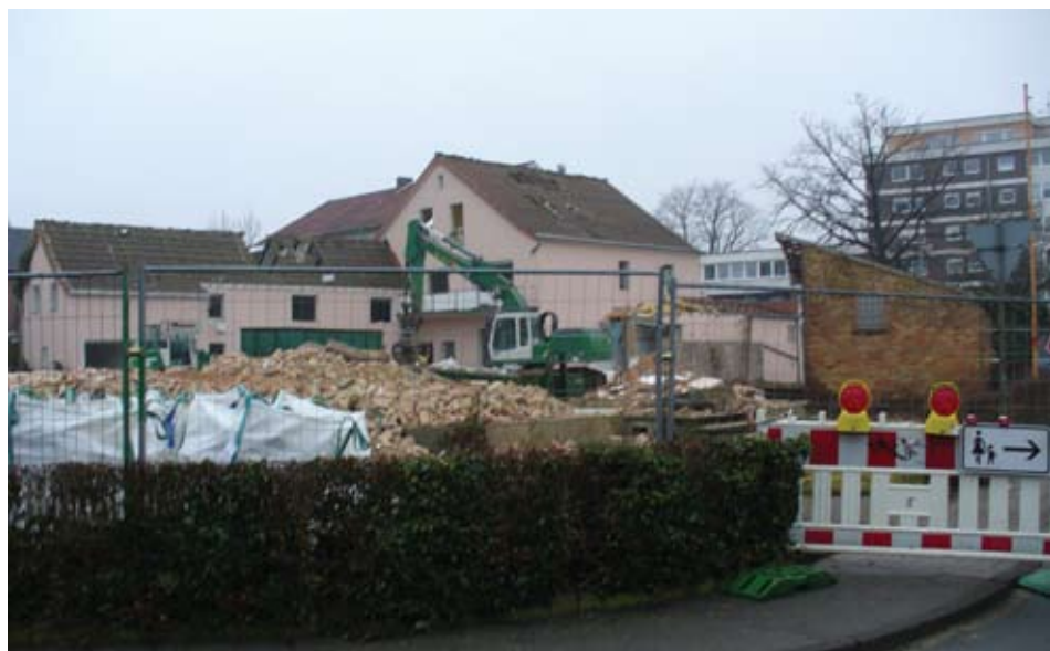
Abrissarbeiten Haus Kürpick und Haus Gehrken, Abbildung: Heimat- und Verkehrsverein Elsen e.V., Foto: Josef Segin 2012
